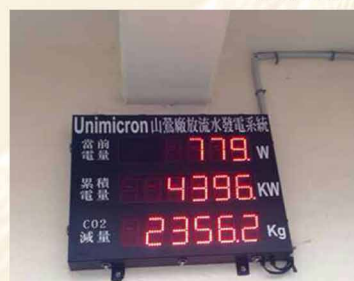
欣興電子 山鷹廠放流水發電系統
